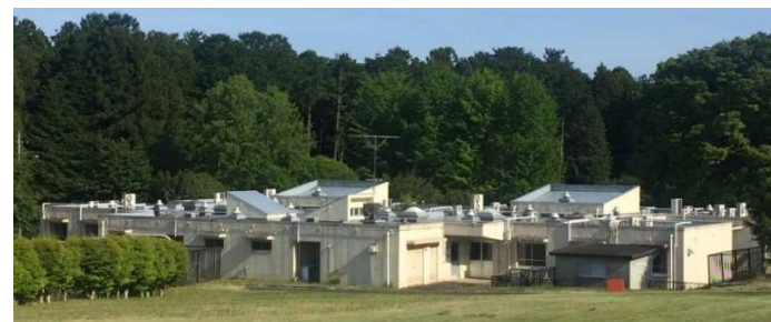
老朽化が進む入所施設（旧棟）
